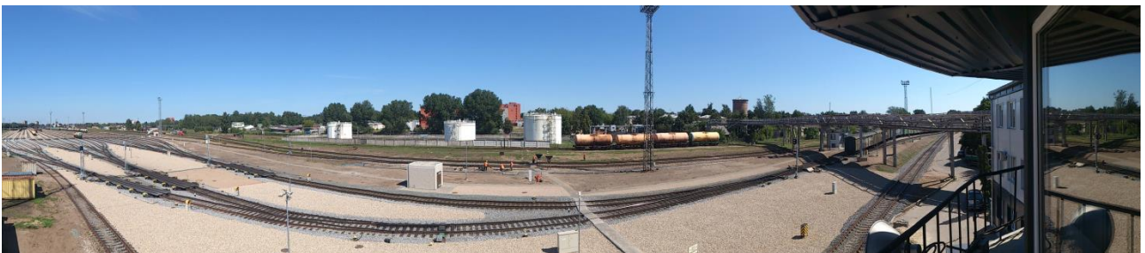
42.att. Notestētais un pagaidu ekspluatācijā pieņemtais šķirotavas stacijas šķirošanas uzkalns
