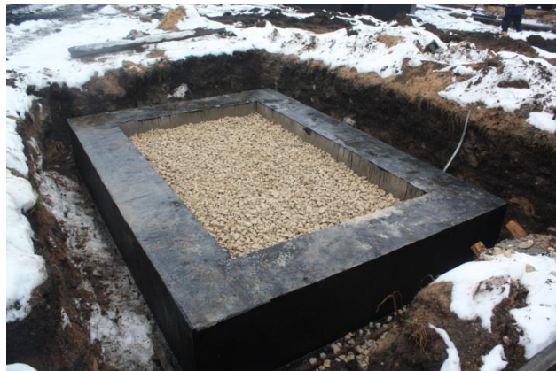
14.att. Sagatavoti pamati jaunajām eļļas apakšstacijām
