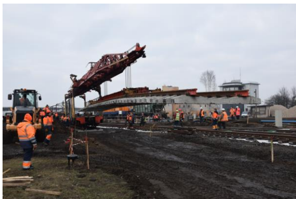
34.att. Pēdējā sliežu ceļa posma būvniecība
