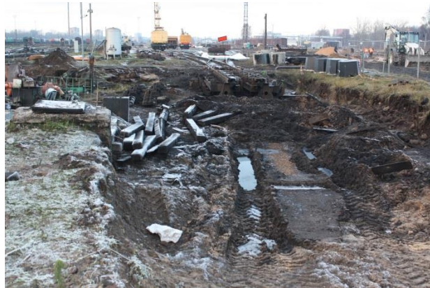
12.att. Veco lēninātāju demontāža
