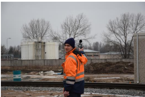
32.att. Skajruņu sistēmas dzirdamības pārbaude
