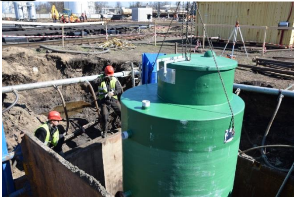
21.att. Ieguldītas drenāžas caurules un uzstādīta notekūdeņu attīrīšanas iekārta
