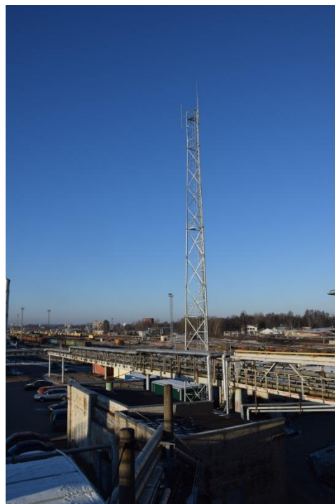
16.att. Iedurti pāļi, iebetonēti pamati un uzstādīts radio tornis
