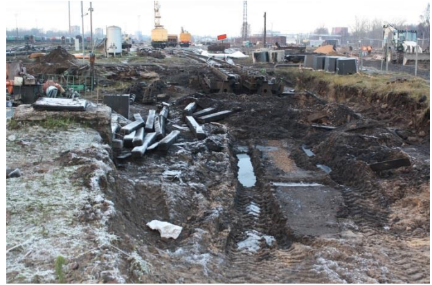
12.att. Veco lēninātāju demontāža
