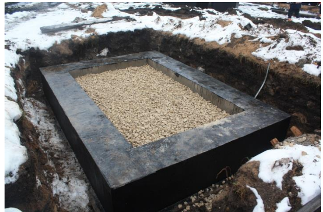
14.att. Sagatavoti pamati jaunajām eļļas apakšstacijām
