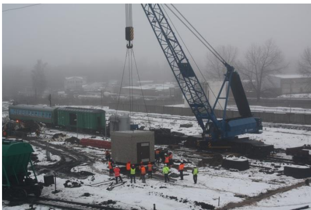
15.att. Tiek uzstādītas eļļas apakšstacijas
