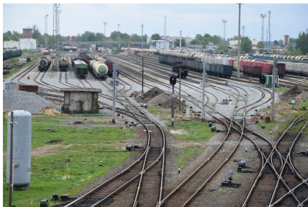
24.att. Pabeigta 2.celju sakopojuma pāra pārmiju sašaurinājuma rekonstrukcija
